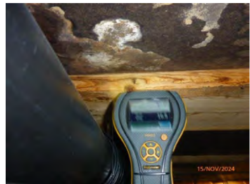
Under toalettrom eller vaskerom
