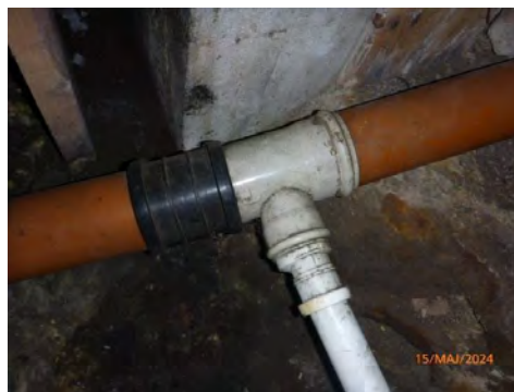
Avløpsrør i krypkjeller.
