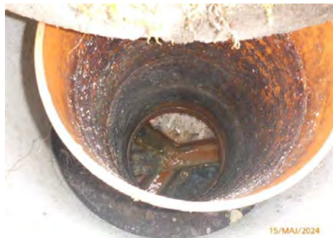
Kum med avløpsrør på tomten.
