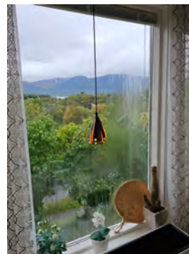
Stuevindu mot øst har dugg mellom glass
