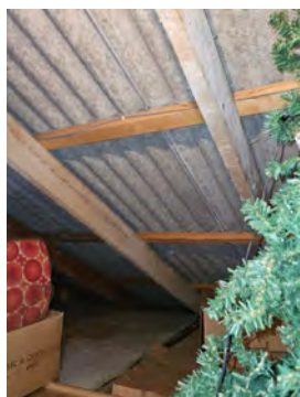
Eternit taktekke benyttet som undertak
