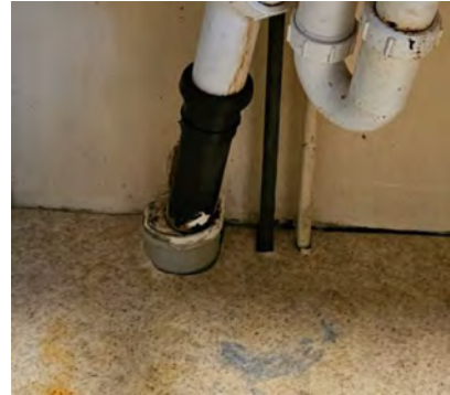
ufagmessig overgang mellom dimensjoner
