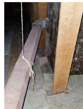
Luftekanal som asbestholdig kanal
