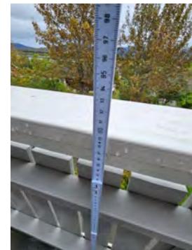
Rekkverk på balkong i øst med høyde 89cm
