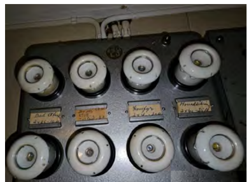
Underfordeling i sokkelen.
