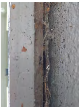
Lite lufting bak opprinnelig kledning
