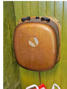
Dagtank for olje plassert på vegg
