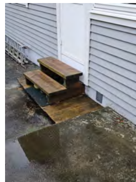
Trapp fra balkongdør til uteareal
