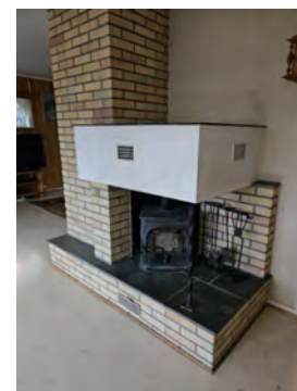
Peis i stue med montert vedovn
