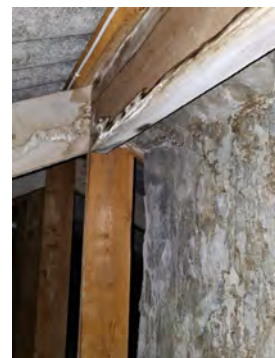
Luftekanal som asbestholdig kanal
