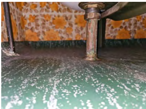
Avløp fra badekar går direkte i rør
