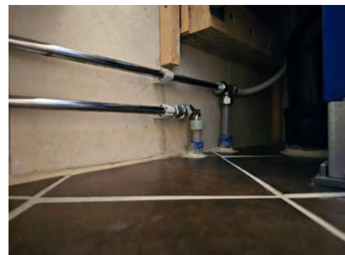
Rørkoblinger i toalettasse.
