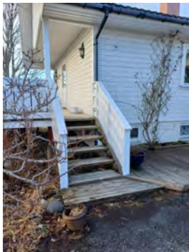
Trapp til terrasse, rekkverk montert i mars 2025.
