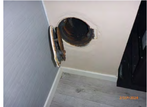
Sotluke for denne og overliggende boenhet.
